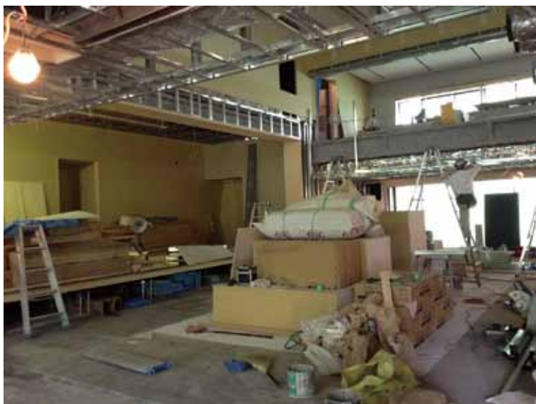
太子堂ホール建築中
