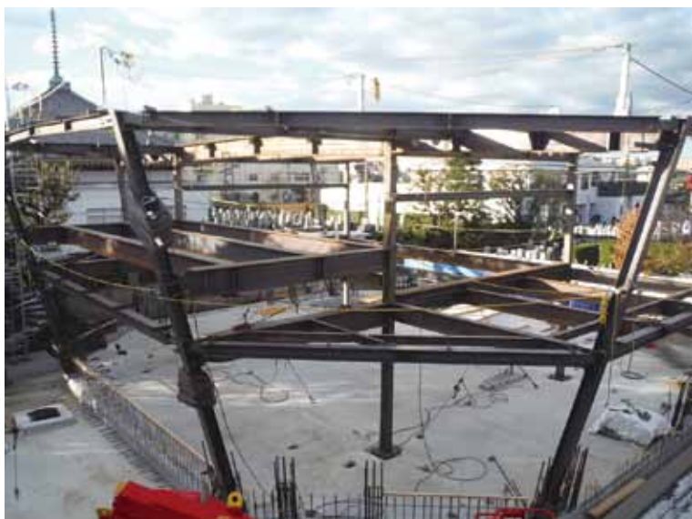
太子堂 鉄骨組み
